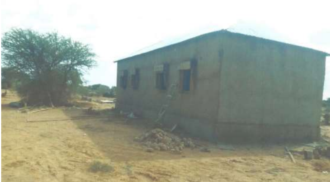
Das Haus mit zwei neuen Schulräumen ist fast fertig.
