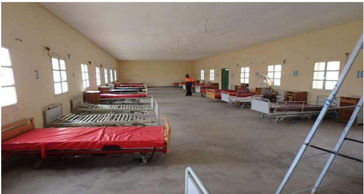
Installationsarbeiten in eine Patientenstation in Gabiley
